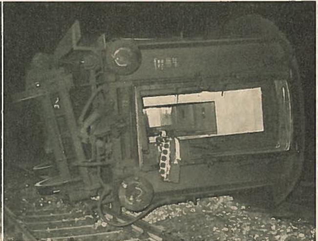
Am 16. April 1970 um 0.20 Uhr entgleiste im Bf W. bei Ausfahrt eines internationalen D-Zuges aus Gleis 2 der 5. Wagen auf Weiche 157 stürzte um und verlegte die Gleise 1 und 2. Ein Bundesbahn-Pensionist und ein Bediensteter der HW Floridsdorf wurden dabei getötet, die übrigen 255 Fahrgäste blieben glücklicherweise unverletzt.
