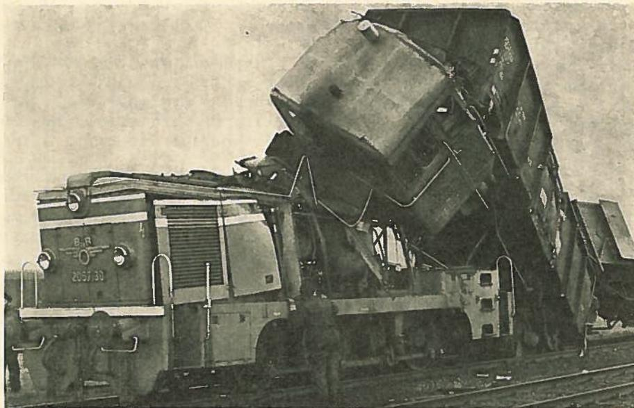
(Zusammenstoß zweier Verschubteile. Schwerste Beschädigung eines Tfz sowie Entgleisung zweier Güterwagen. Sachschaden: zirka S 400.000!)
