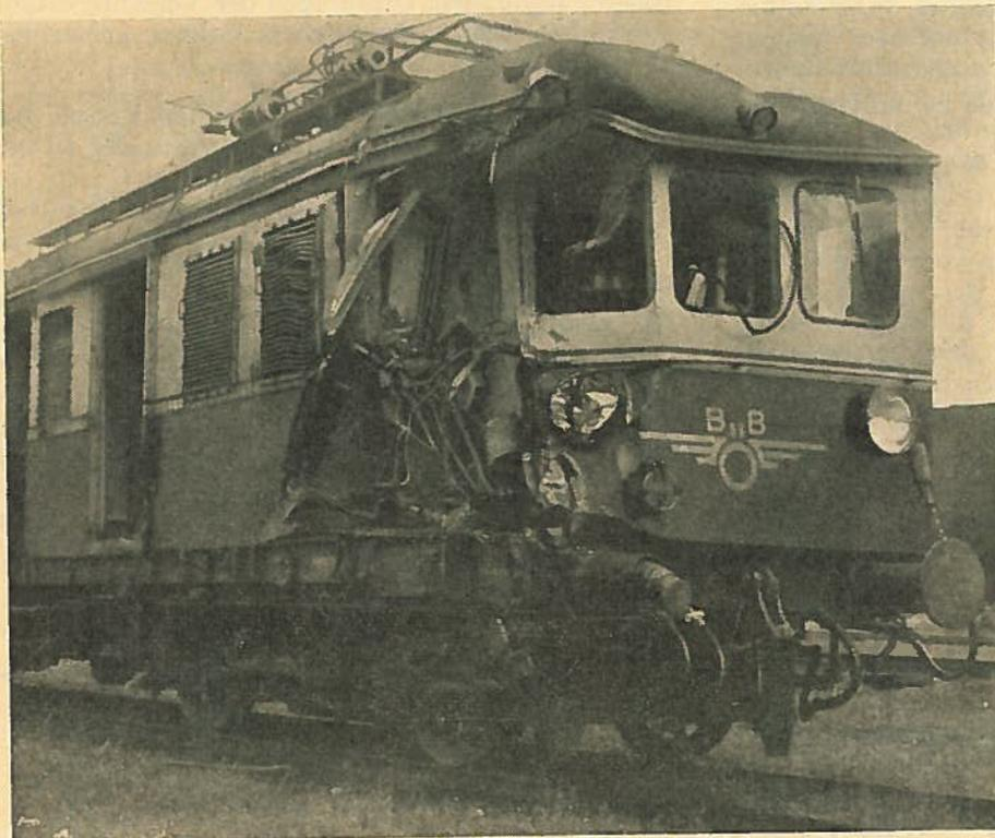
Der schwerbeschädigte Führerstand des Triebwagens
