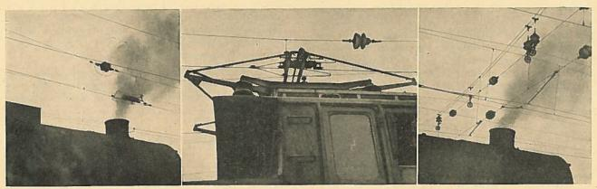
Gemäß Punkt 97 der DV El 52 sollen Streckentrenner durch die Stromabnehmer stehender elektrischer Triebfahrzeuge nicht ganz oder beinahe überbrückt werden; Dampflokomotiven sollen wegen der besonders nachteiligen Verrußungsgefahr und der Möglichkeit von Überschlägen nicht unter Streckentrennern stehenbleiben oder längere Zeit unter Querseilfeldern und Querseiljochen in Bahnhöfen halten!
