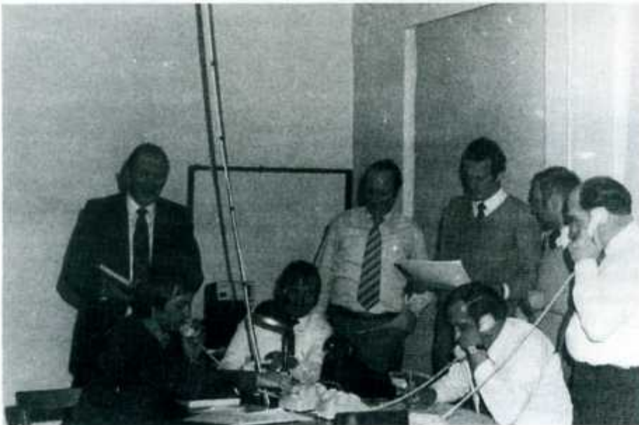
Ein Blick in die Mil-ZÜ im Bf Fehring
