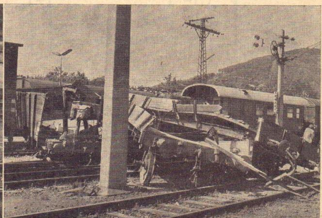
Von einer auf Gleis 106 abgestellten Wagen-Gruppe (35 Wagen) sollten 17 Wagen nach Gleis 8 vorgezogen werden. Der Verschiebler ließ diese abkuppeln und sicherte die stehengebliebenen Wagen nur durch Unterlegen mit 2 Hemmschuhen, wiewohl 2 Handbremsen vorhanden waren.
