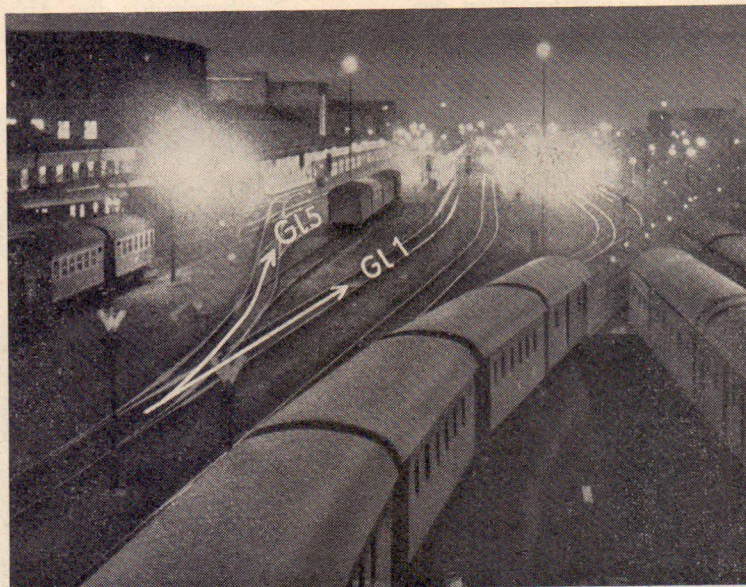
Blick vom Stellwerk 3 in Richtung Hallegleise
