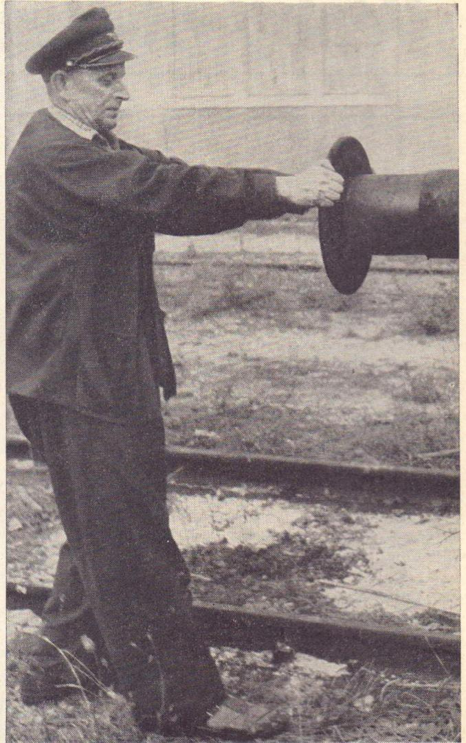
Sodann ist durch eine Dreh-Ziehbewegung zu versuchen, den Puffer zu verdrehen. Kann dabei der Puffer auch nur geringfügig herausgezogen werden, so ist der Wagen als Gebrechenwagen zu behandeln (Abbau schadhafter Puffer oder Puffer-teile, allenfalls Abstellen des Wagens. Entsprechender Vermerk auf dem Gebrechenvormerk, Vordruck M 31-10, über den Verbleib der abgenommenen Teile.)
